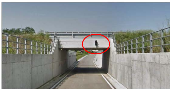
Figura 5.6.b: sottopassaggio di Strada Belpensiero sotto SP 159 (si noti l'impianto semaforico di stop e si veda inoltra tavola 10)
